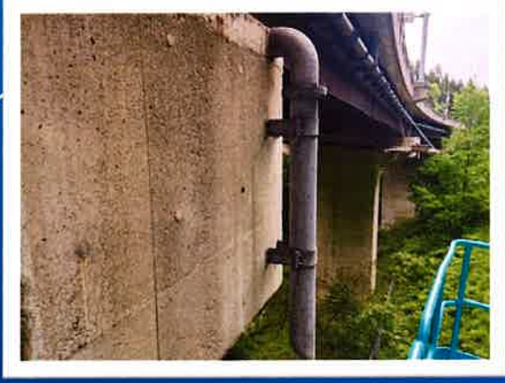
排水管の腐食
