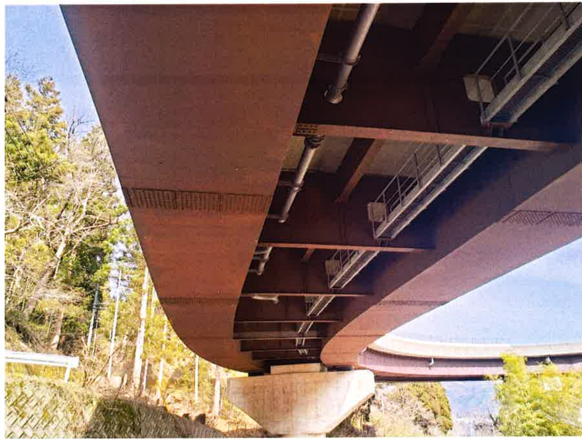
塗装してない橋（耐候性鋼材）
